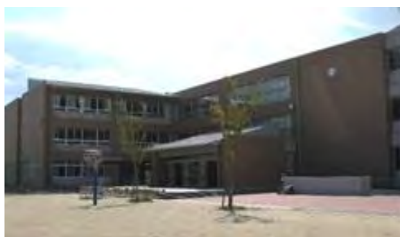
対象施設外観 (四日市市立港中学校)
